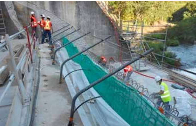
Des ancrages passifs installés dans le barrage. © Grégory Coubard
