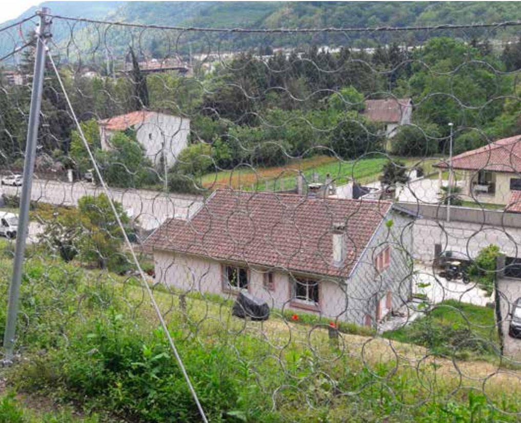
Installé au-dessus des maisons, à Foix, en Ariège, cet écran de protection protège les bâtisses contre les chutes de blocs.
