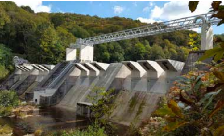
Un barrage après renforcement. © Grégory Coubard
